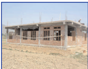
Centre en construction
